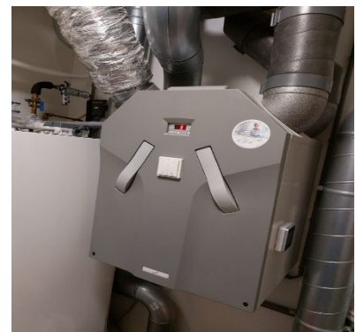
Afb.3: De Warmte Terugwinkast.
